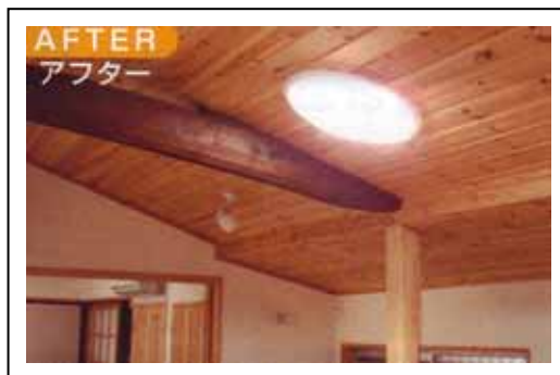
スカイライトチューブを設置した室内
