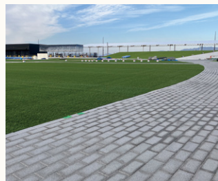
大阪・関西万博会場に敷設されたCUCO ® -舗装ブロック（写真提供：鹿島建設）
