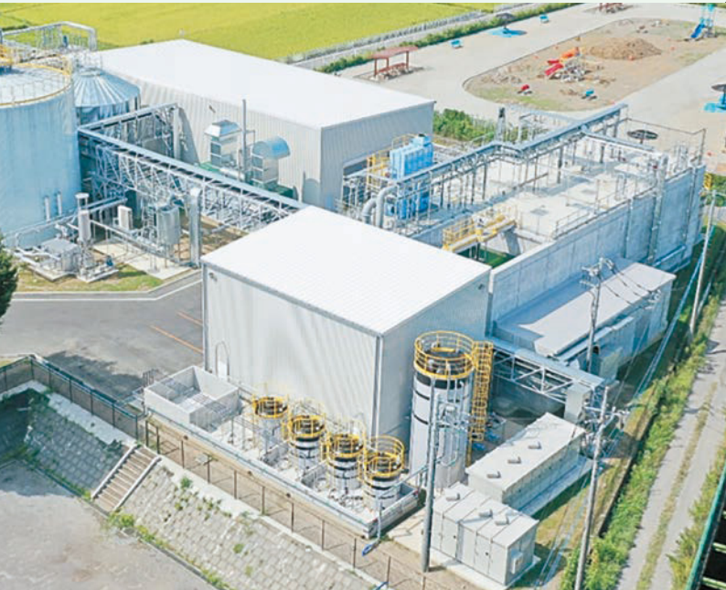
ふじみ野市にあるNEFCバイオガス発電プラント。食品関連事業者から出される食品廃棄物を処理し、そこで得られたバイオガスをを用いて発電する。
