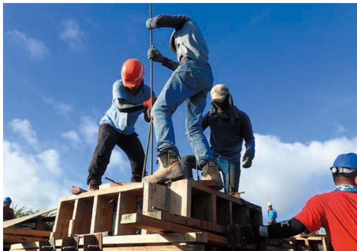
フィリピン初号機の工事の様子。大型クレーンを使えない発展途上国の離島での建設性を向上させる取組として、重機を使わずに建てられた。
