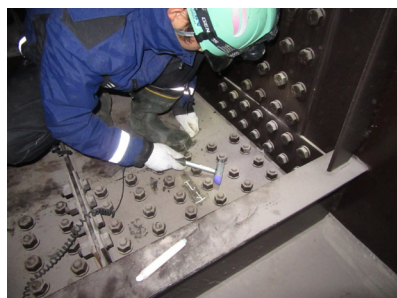
測定状況(ボルトテスター)
