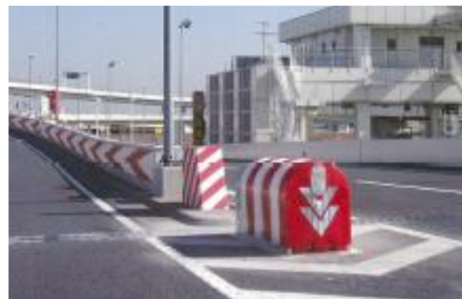
＜高速道路に設置されたショックプロテクター＞
