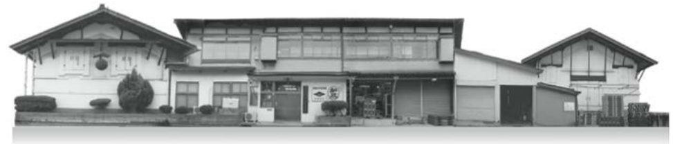
＜蔵及び事務所の外観＞
