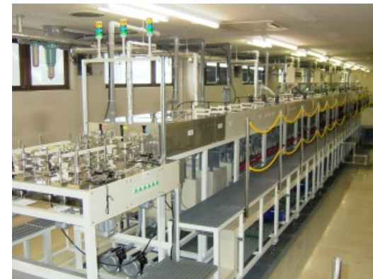
< フープ鍍金装置 >
