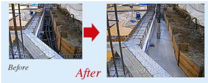
＜共同住宅の基礎廻りでのスラモルの施行例＞
