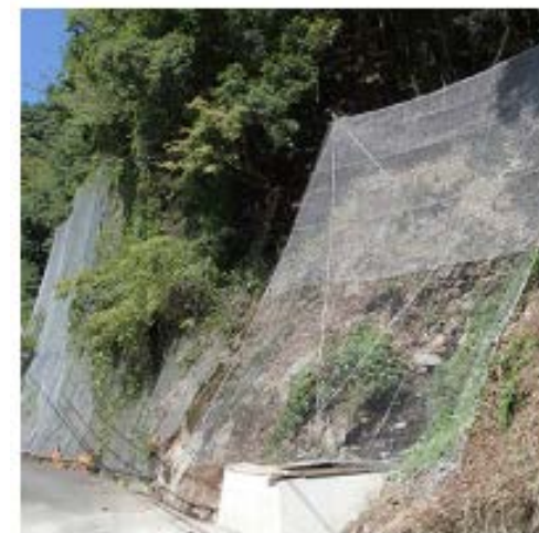
＜落石対策：防護工＞
