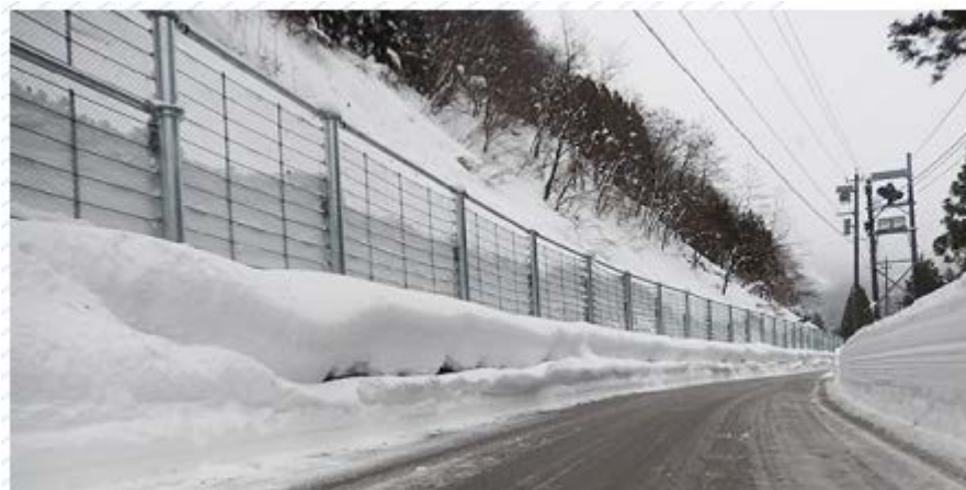
＜雪崩対策：道路沿い＞
