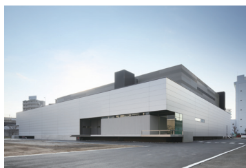
再生・細胞医薬製造プラント (SMaRT)（大阪府吹田市）
