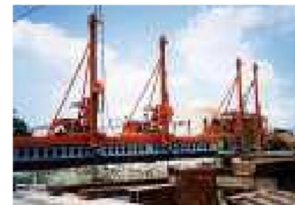
シンガポール SS-40V-600 河川(運河)改修工事
