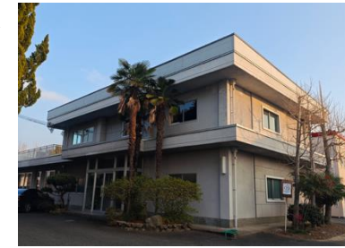
本社 社屋外観
