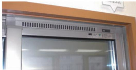
▶住宅用窓サッシの自然換気装置
