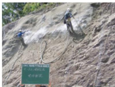
▶ セーフマン吹付工法（フライアッシュプレミックセメントによる低リバウンド吹付工法）
