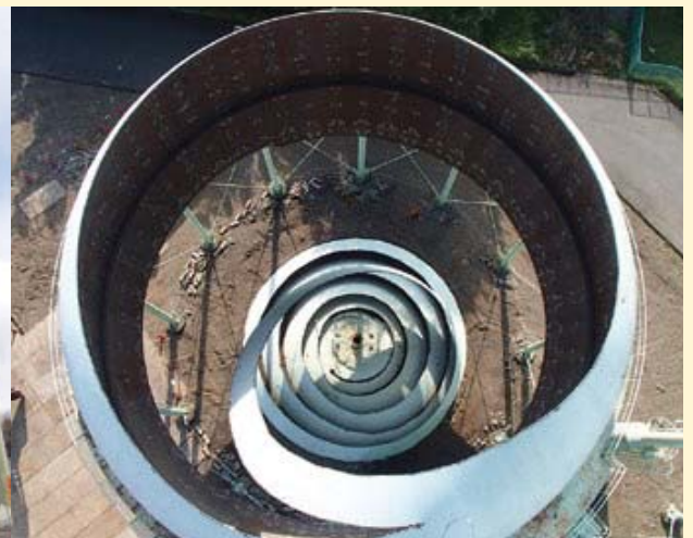
球形ガスホルダー解体工事②
