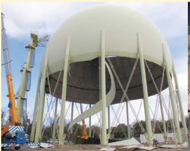
球形ガスホルダー解体工事①
