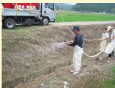
芝生吹付け作業
