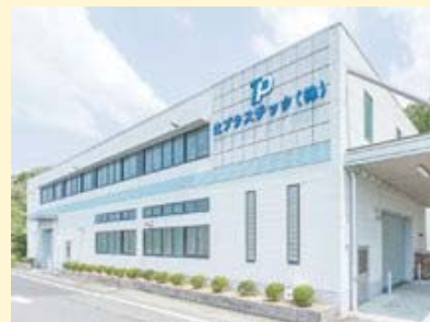
太陽光発電を利活用した製品開発する専用工場
