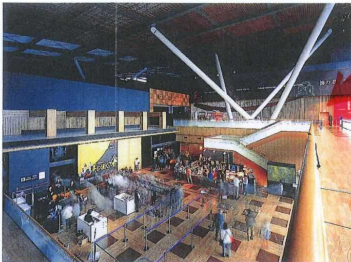
3階特別展示室前に広がる展示ロビーまわり。展示室への出入りは、ここから行う。奥に見える鉄の柱は、地盤面から建ち上がり、大屋根を支えている。展示室まわりの免震構造とは縁を切っている
