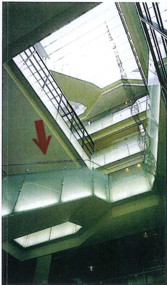
吹抜け部見上げ。エスカレータの傾斜は35度でスパイラル状に配置されている。／左：同見下ろし。
