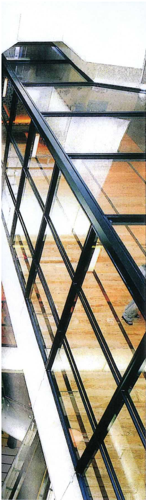
吹抜け部見上げ。エスカレータの傾斜は35度でスパイラル状に配置されている。／左：同見下ろし。
